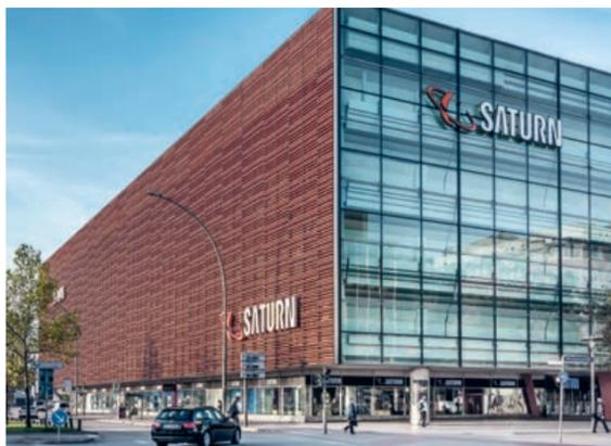
Für die Optik eines Superlangziegels sorgen je drei Klinker-Baguettes in den Sonderformaten 575 x 150 x 71 mm, die auf einem Aluminium-Tragsystem aufgefädelt wurden. © Anke Müllerklein
